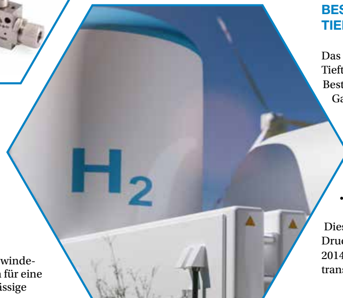
Wasserstoffspeicher, Kompressoren und Druckkontrollgeräte
